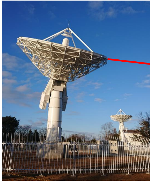
口径13.5m月探査機運用地上局 (2023年度に完成)
